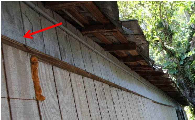
Long length of PVC conduit
